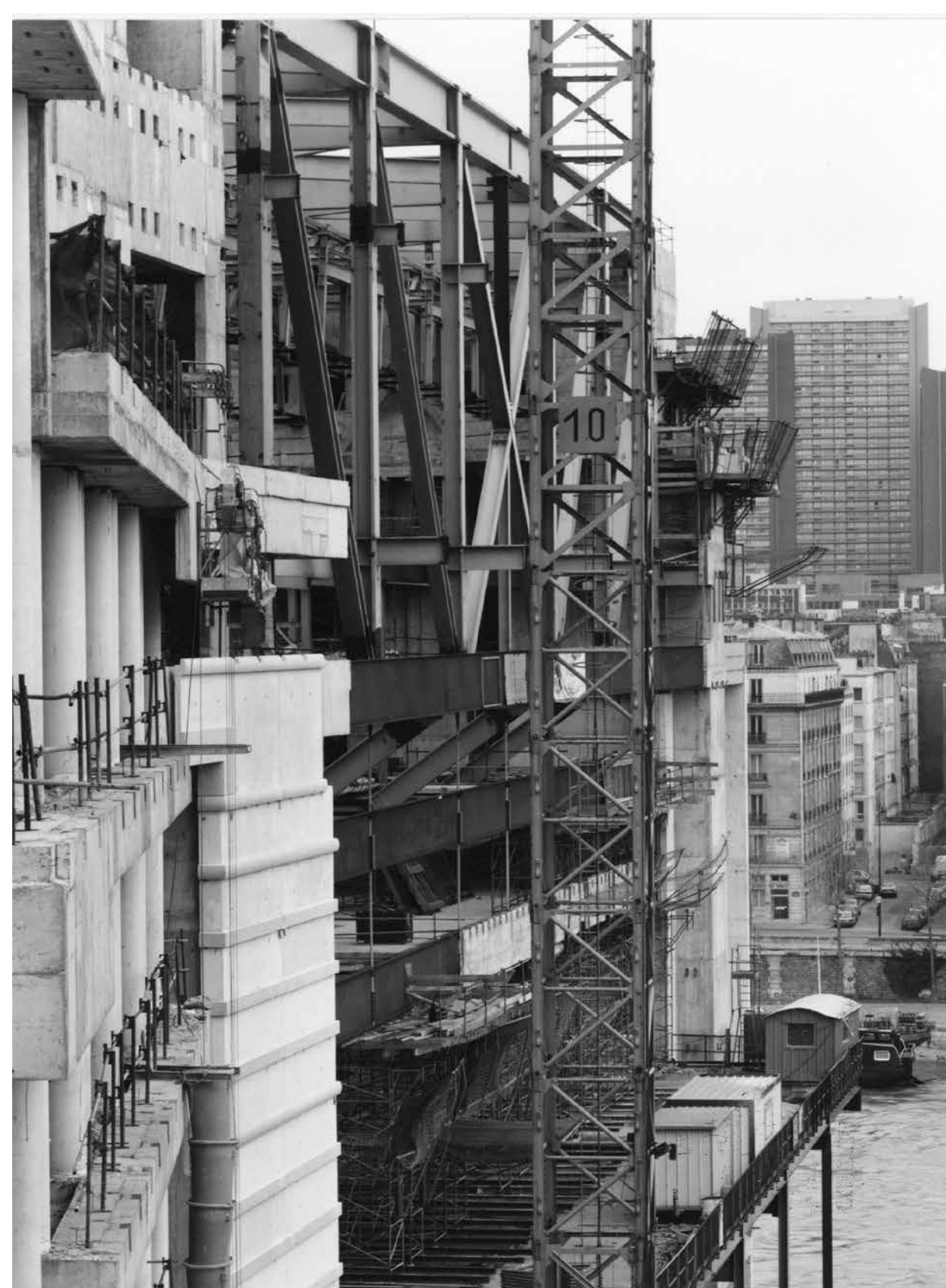
Construction de la pile en Seine, début 1986
