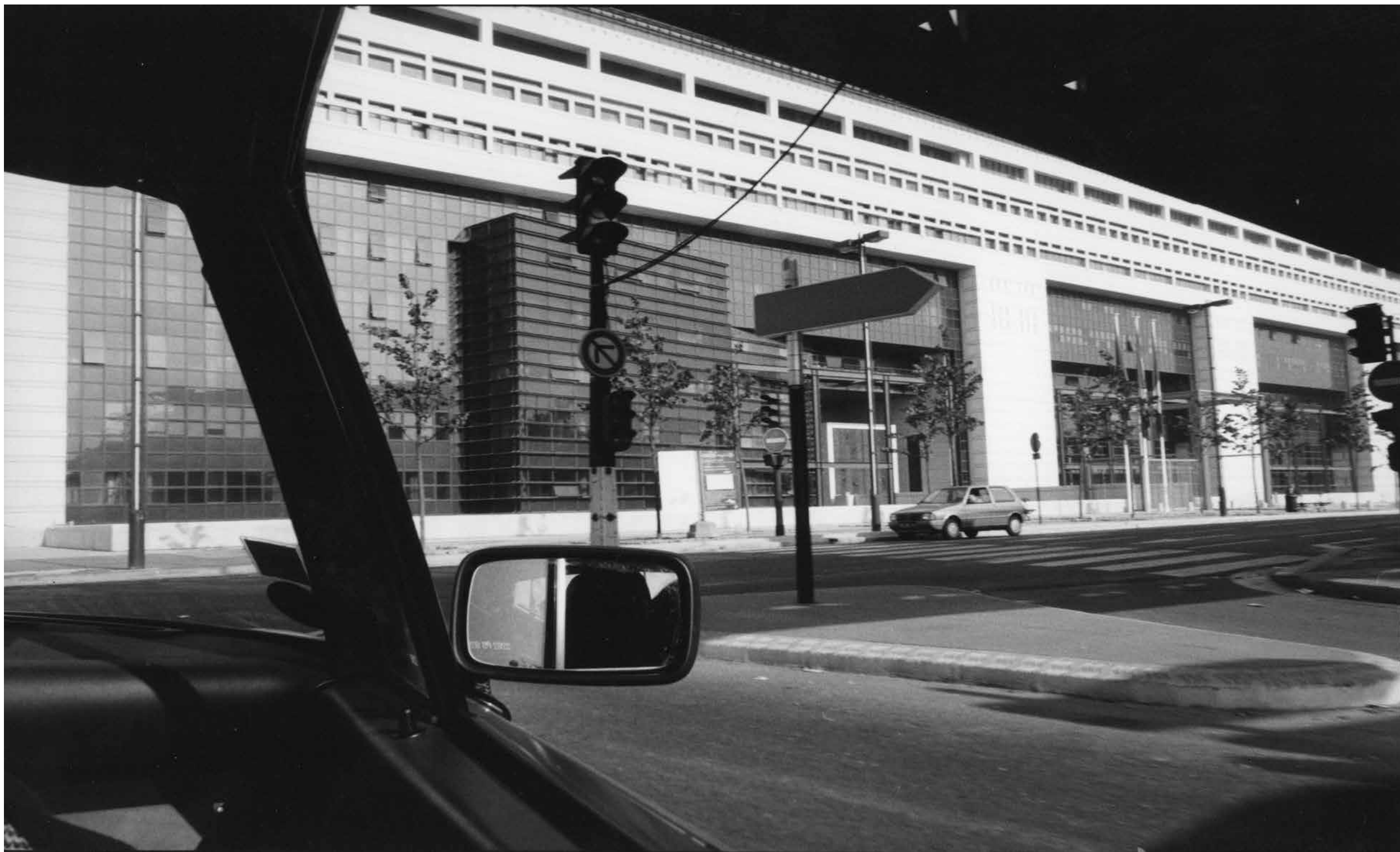
Façade sur rue depuis le quai de Bercy Photographie de Laure Vasconi, octobre 1989
