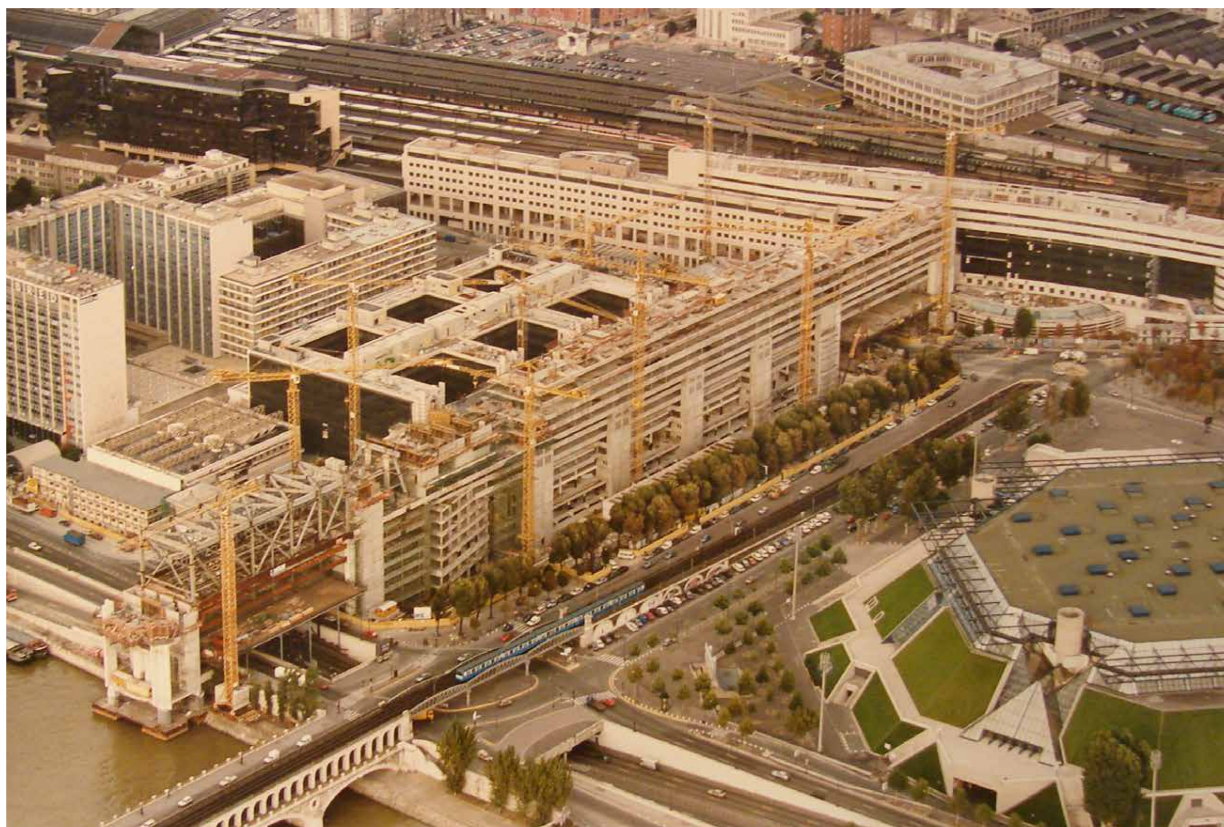
Vue du chantier fin 1986
